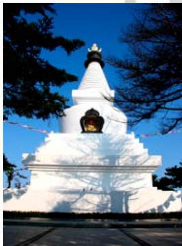
廬山諾那舍利塔整修完成
